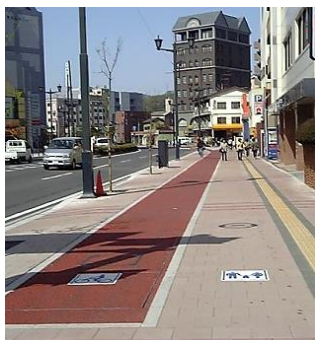
歩道における歩行者と自転車の視覚的分離の整備事例
